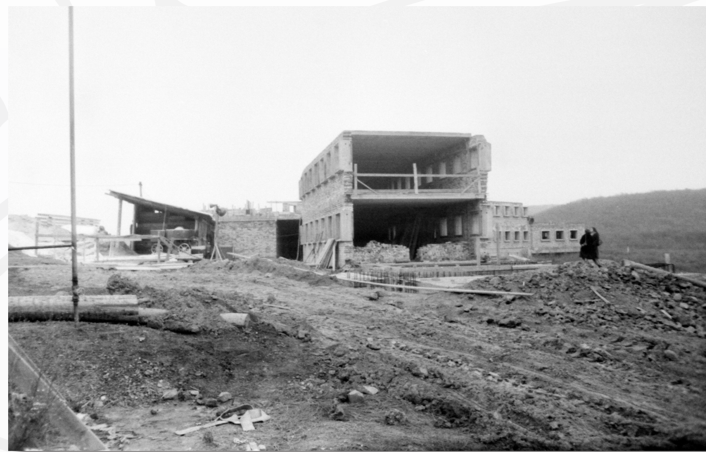
A készülő fal- és födém szerkezetek
