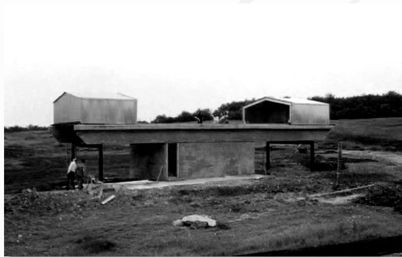
Az észlelőház építés közben
