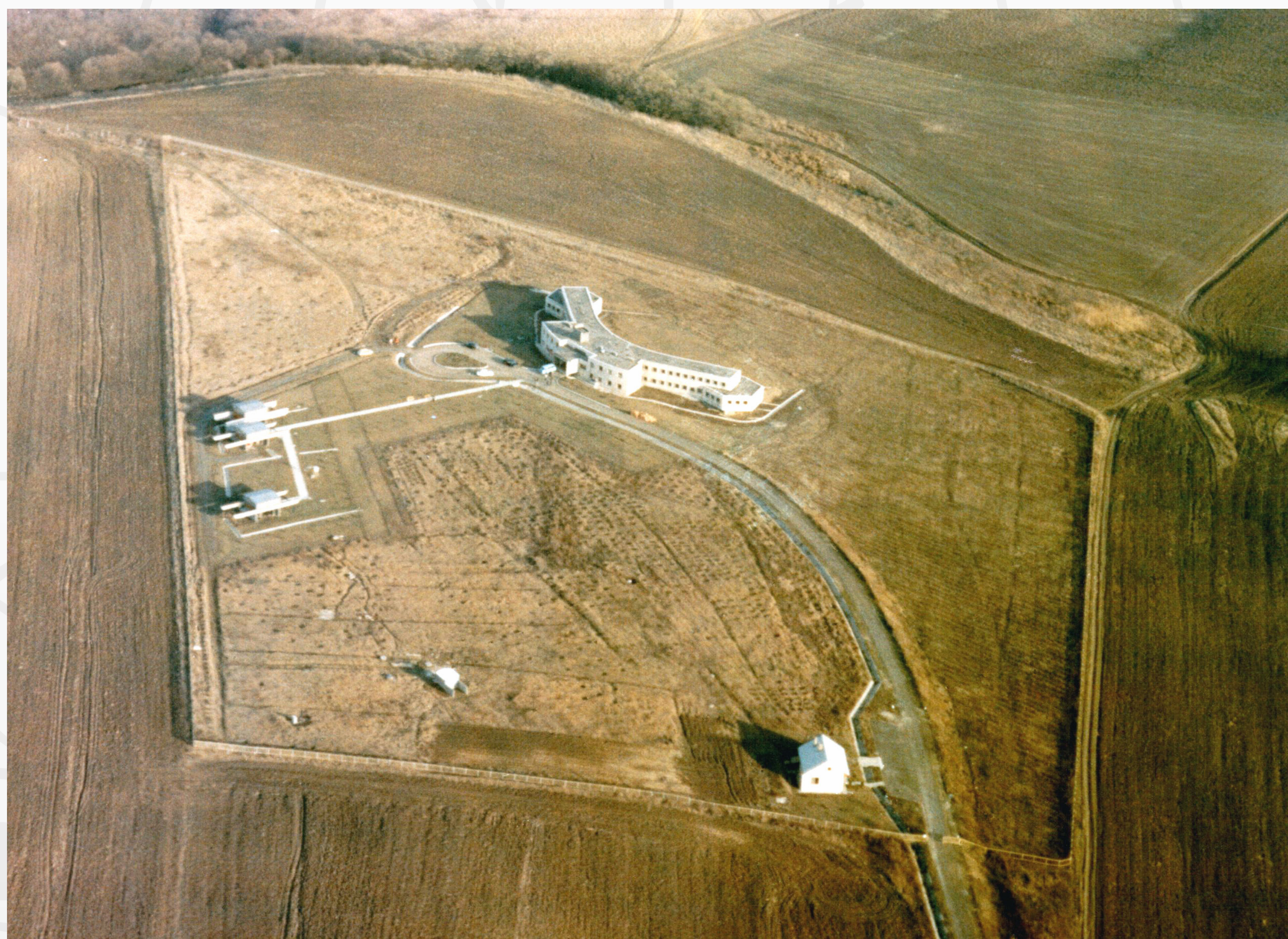
A Kozmikus Geodéziai Obszervatórium épülete és környezetének felvétele helikopterről 1979-ben
