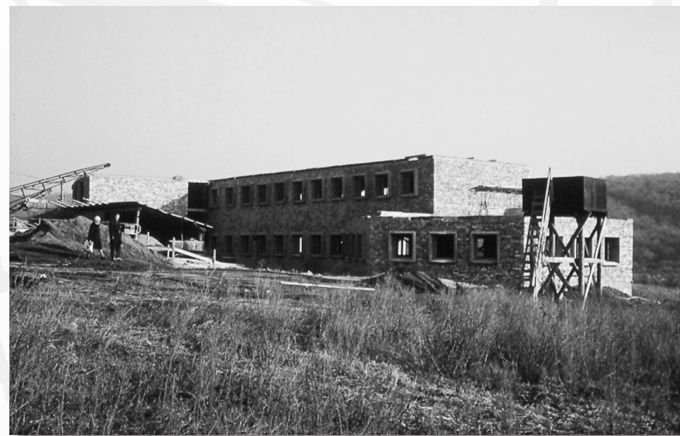
A már csaknem kész teherhordó szerkezetek
