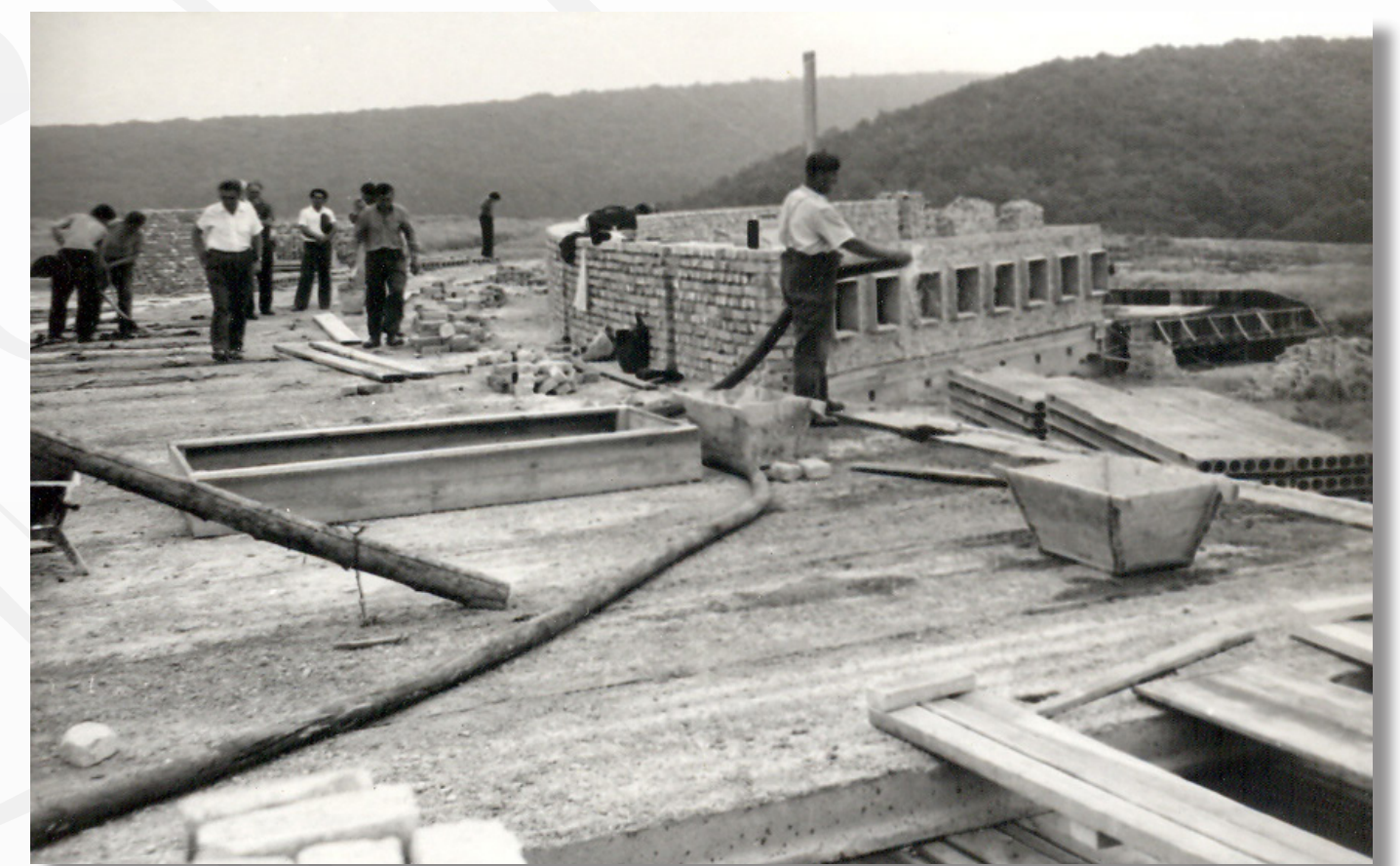
Építési szemle a főépület tetőszerkezetén
