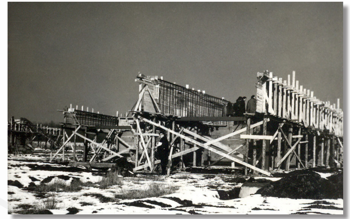
A megfigyelőházak vasbeton zsáuzata
